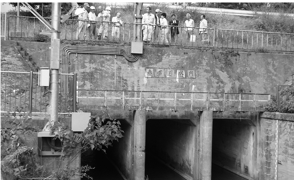
市内の樋門整備を(赤田川樋門)
