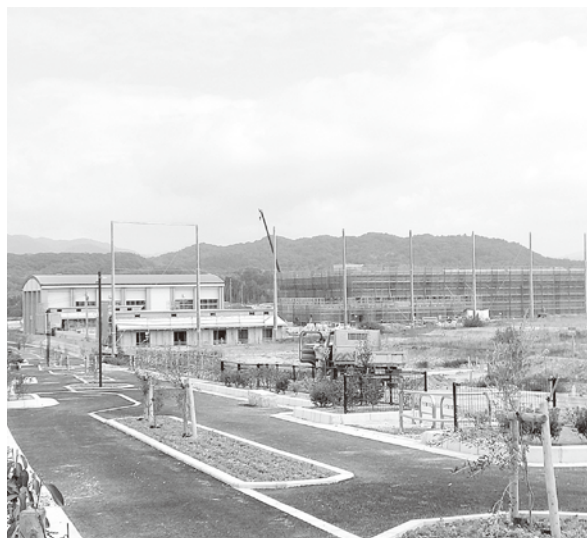
建設進む城山台小学校
