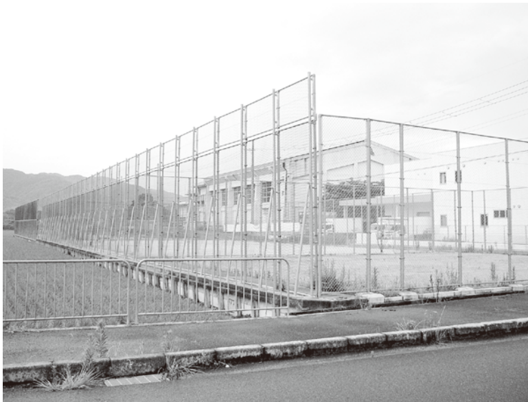
改修が決まったテニスコート（泉川中学校）
