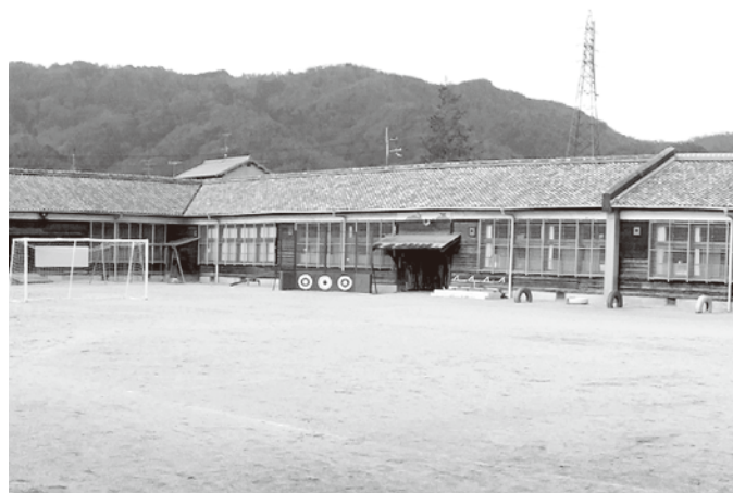
耐震補強工事が
