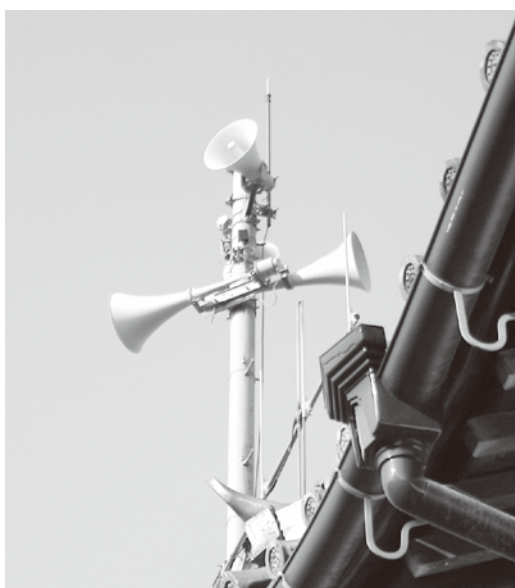
防災無線の整備が進む（屋外拡声子局）
