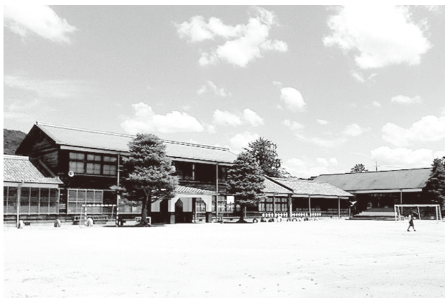
早急な耐震補強を (恭仁小学校)
