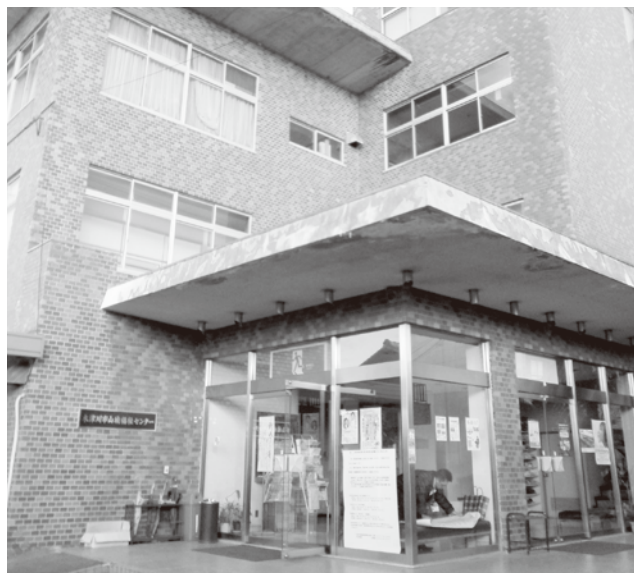
解体される山城福祉センター
