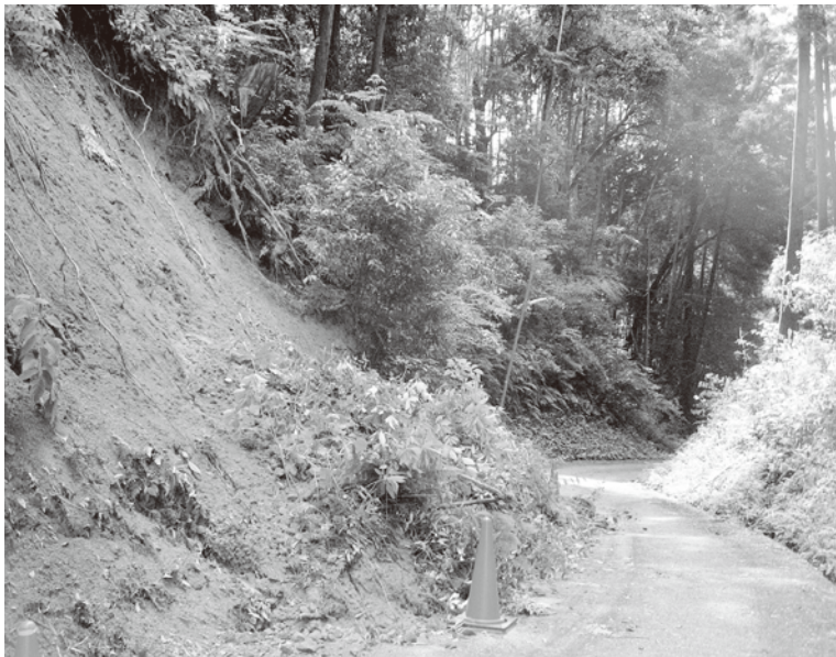
豪雨により被害を受けた市道（岩船）
