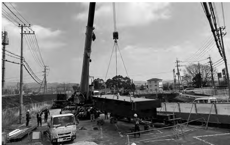
近鉄木津川台駅前の歩道橋工事
