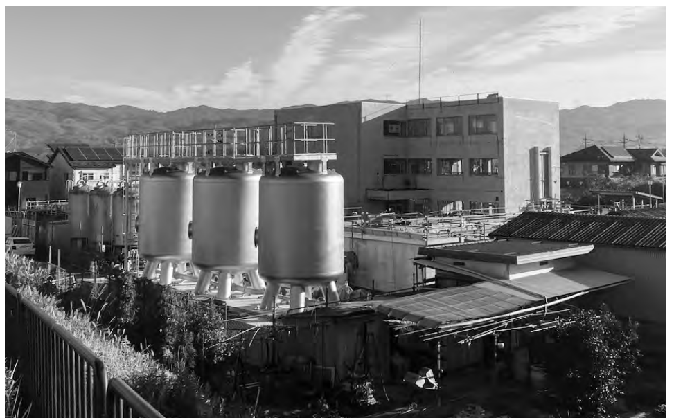
7年度末に一部稼働予定の山城浄水場
