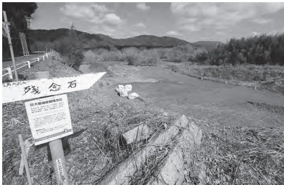
安全な道路を作るため盛土工事が進む（大野バイパス）
