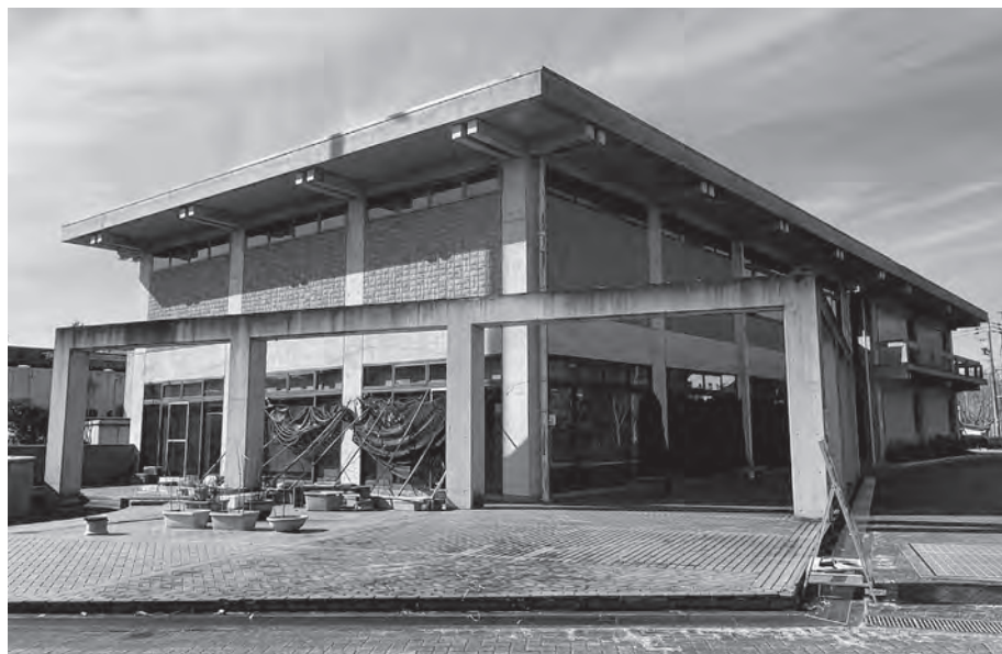
受水池の更新等を予定している吐師受水場（上下水道部庁舎）
