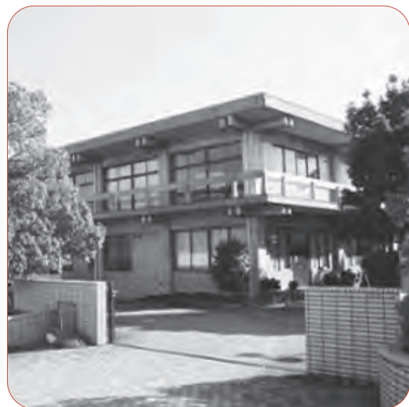
早急に耐震化工事の着工が必要な吐師受水場
