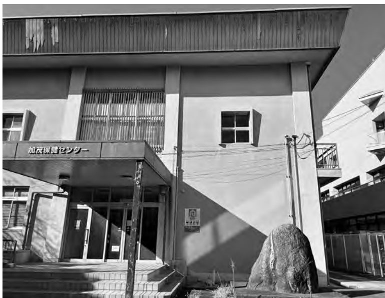
解体撤去される加茂保健センター
