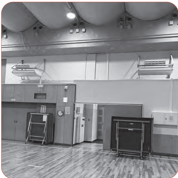
LPガスによるエアコン設置体育館（八幡市男山東中学校）
