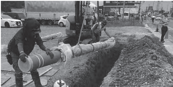
老朽化対策が進む水道工事
