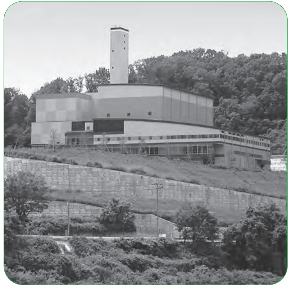
懸案であったクリーンセンターが完成
