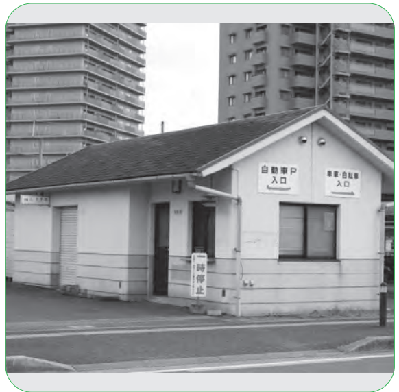
閉鎖された加茂駅西の駐車場トイレ
