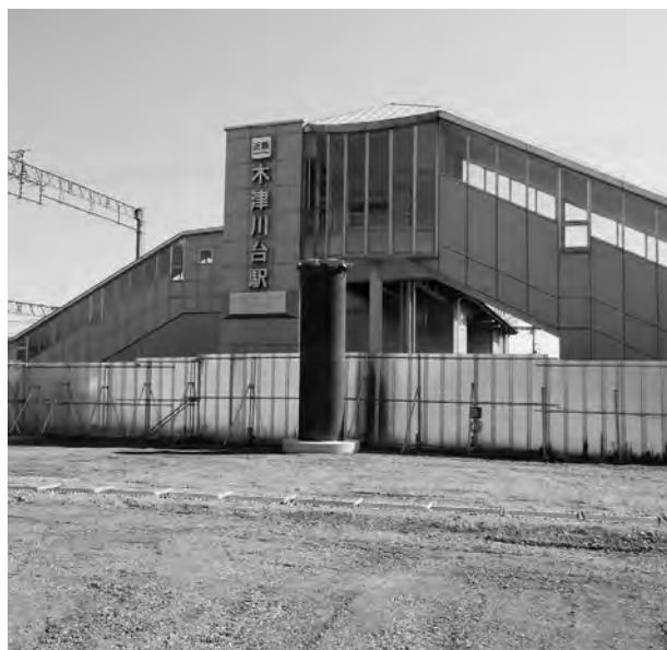
工事が始まった木津川台駅歩道橋
