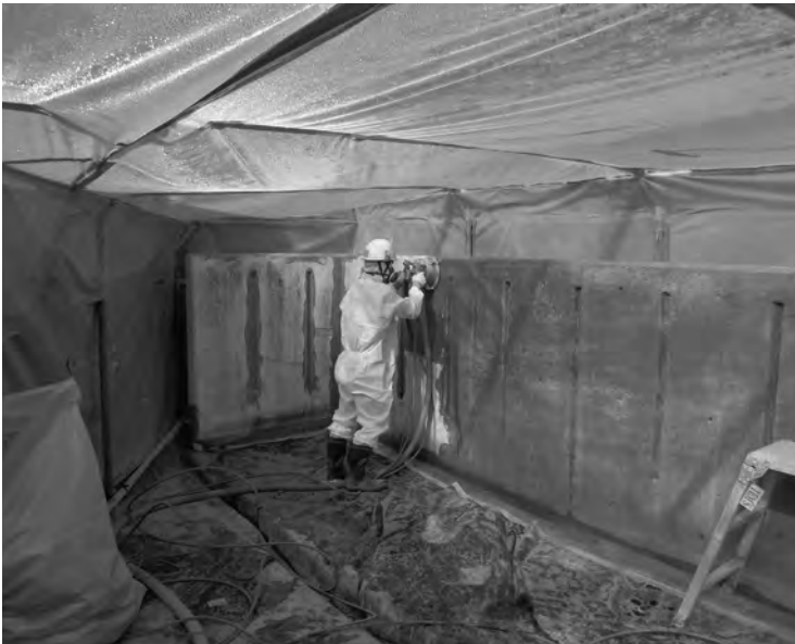
アスベスト撤去工事
