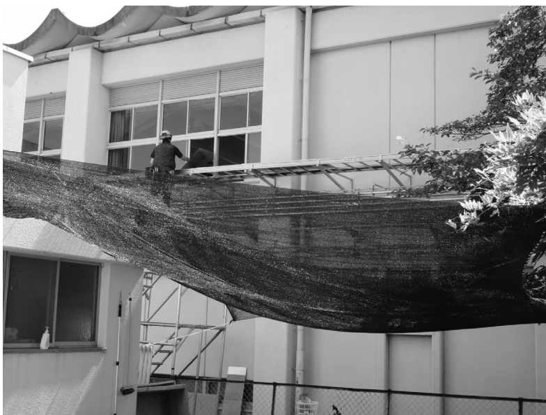
工事予定の南校舎（相楽小学校）
