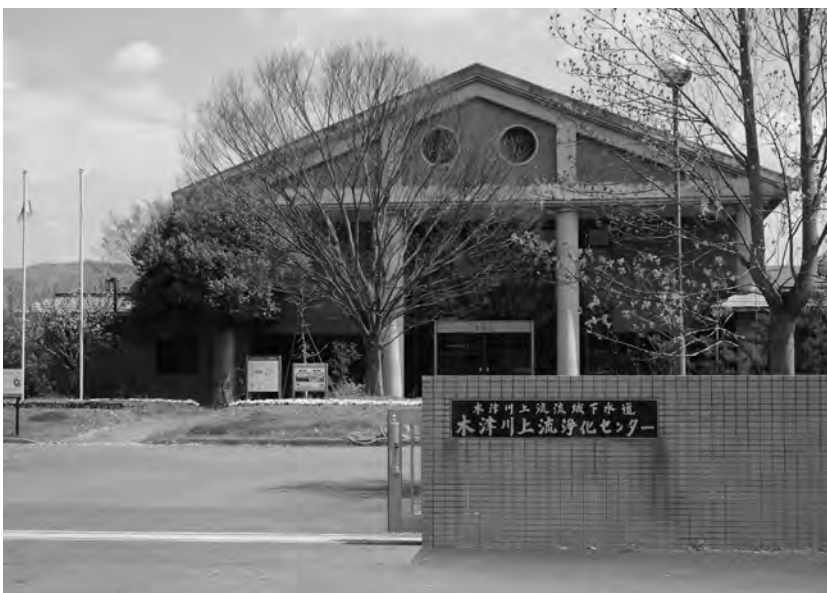
木津地域の污水が処理されている木津川上流浄化センター
