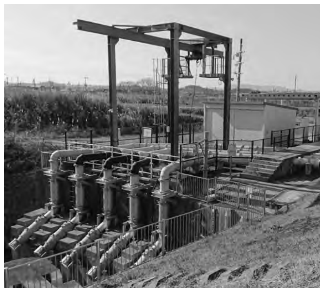
新たに排水ポンプを設置し浸水対策を強化（現在の木津合同樋門）
