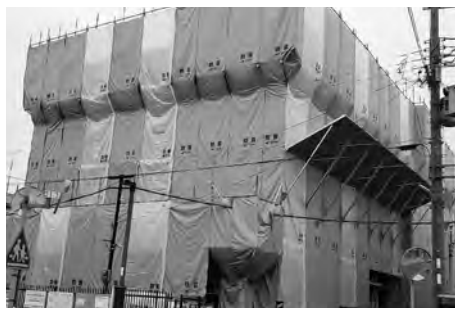
改修工事中の相楽小学校（中校舎）
