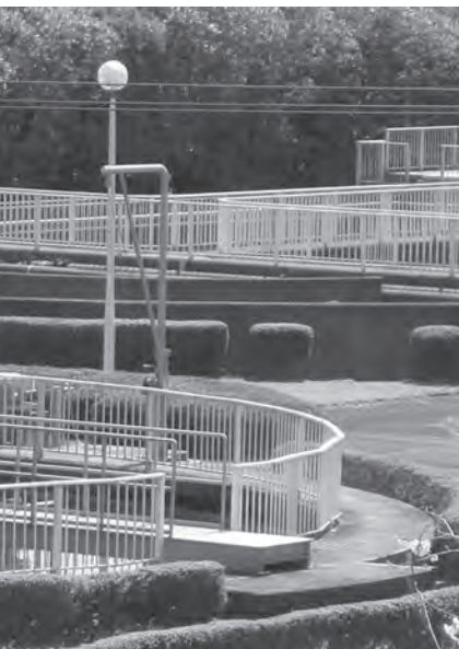
加茂浄化センター
