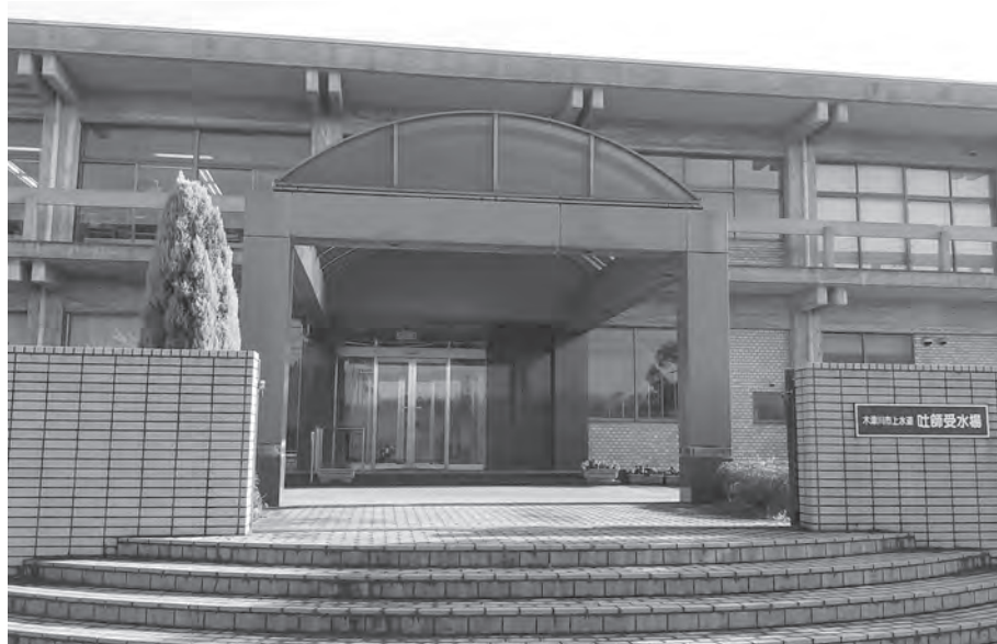
『下水道料金の値上げをする前にすることがある』
