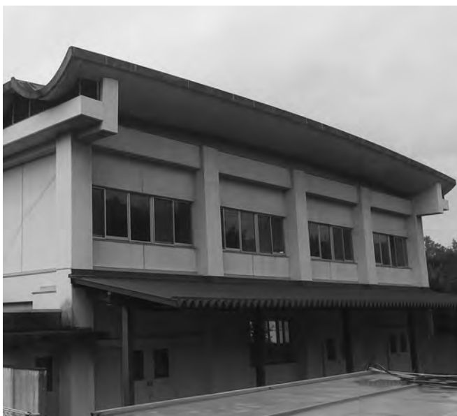
解体される旧木津学校給食センター
