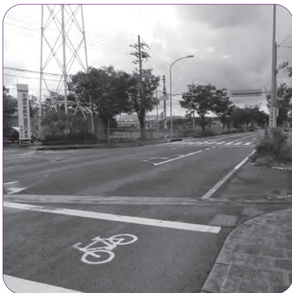
ガードレールが設置される交差点（中央体育館前）
