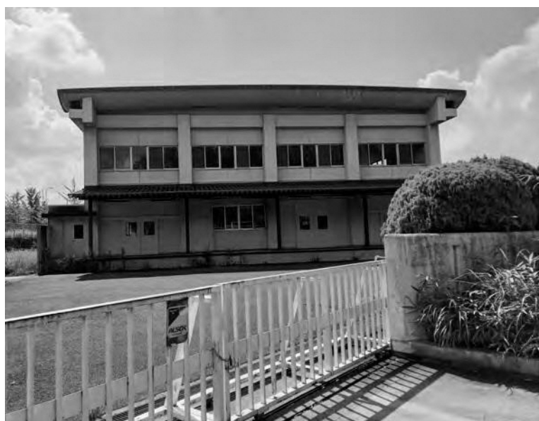
解体される旧木津学校給食センター
