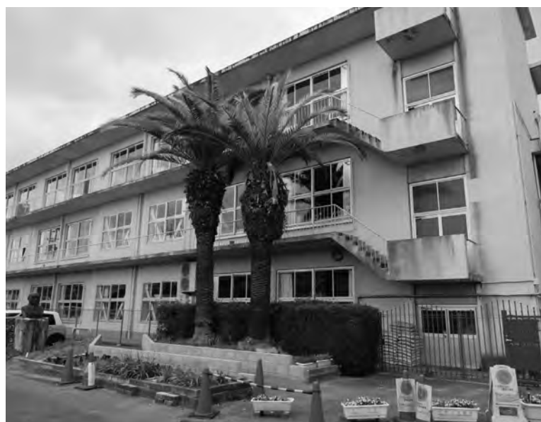
老朽化した学校施設の改修（木津小学校）
