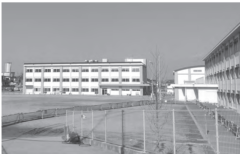
なぜ 第2体育館建設工事が先なのか（城山台小学校）
