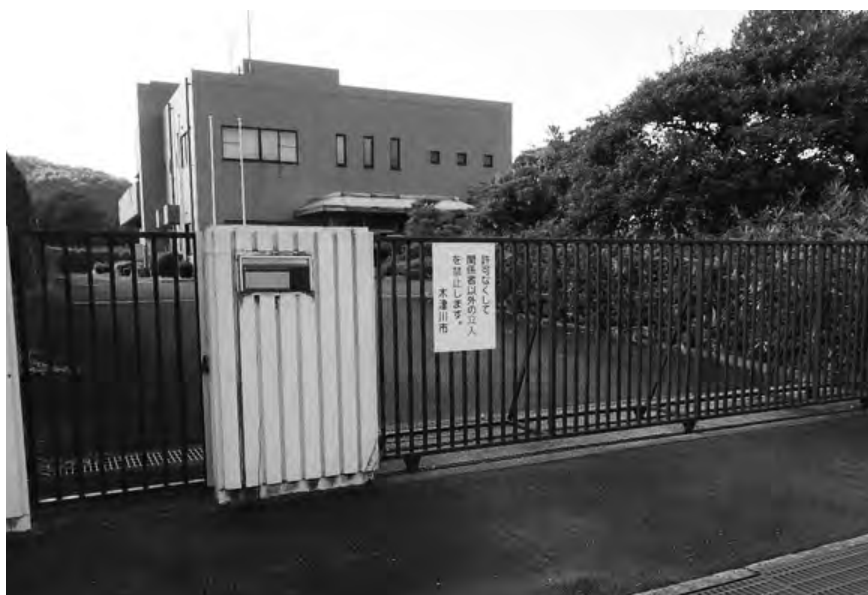
設備の更新が行われる加茂浄化センター
