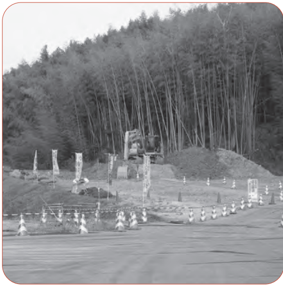
巨大な土砂の山が消えた消防署予定地（城山台9丁目）
