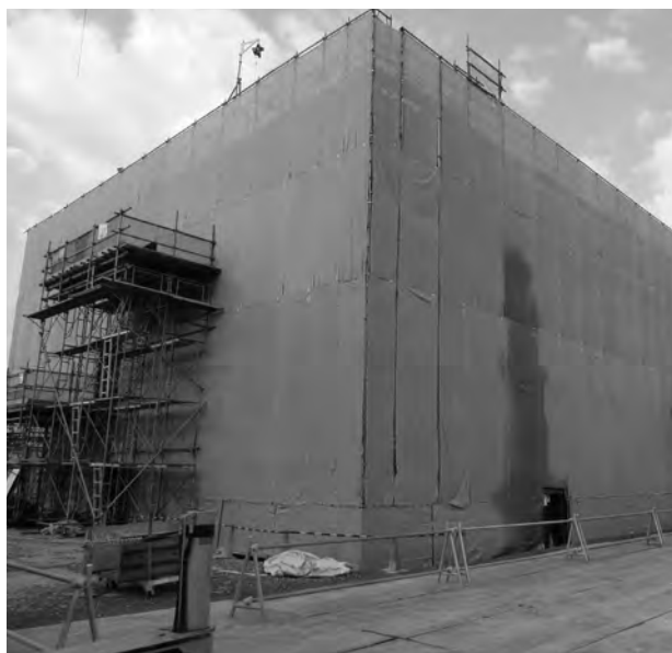
城山台小学校の校舎増築現場(Ⅱ期工事)
