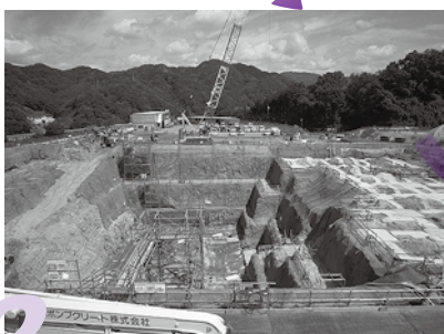
ごみを一時的に貯めるごみピット (地下部)の工事(28年8月)
