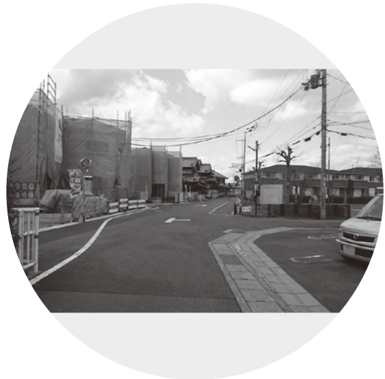
危険でいびつな道路
