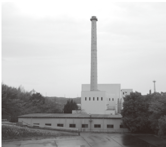
老朽化が進む打越台環境センター（精華町）
