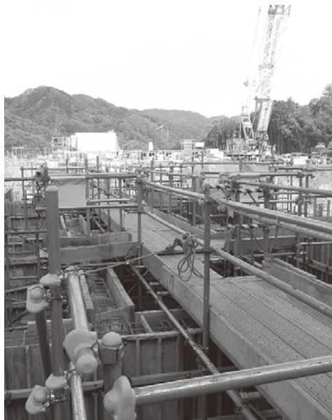
プラットホーム工区の状況（11月30日）
