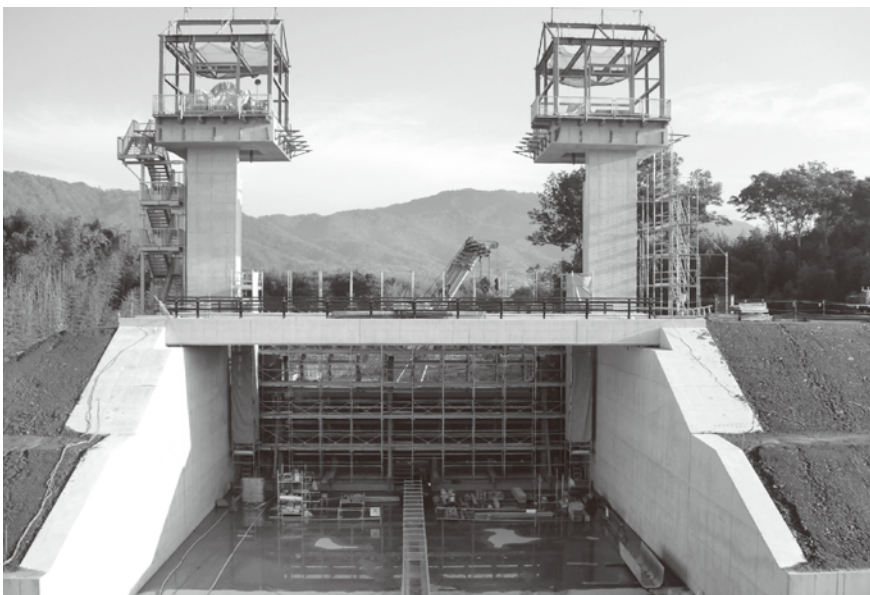
念願の赤田川樋門がよいよ完成に近づく（加茂地域）
