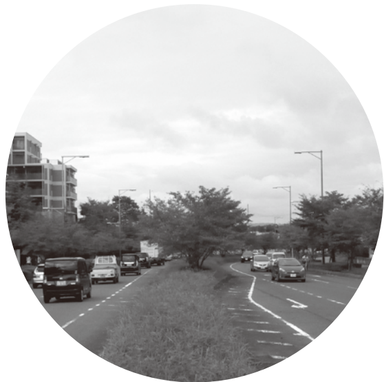
維持管理費が高つく東中央線（州見台）
