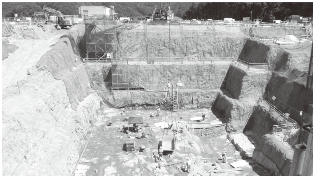
掘削完了したごみピット工区
