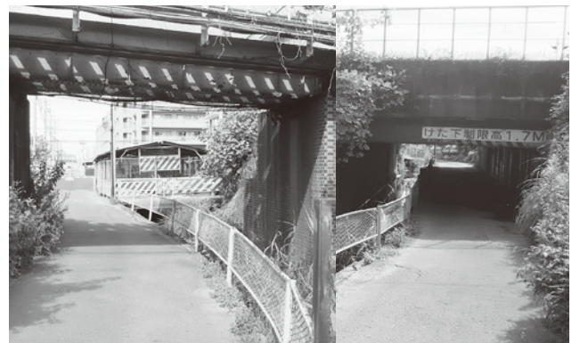
早期に幹線道路としての整備を（JR木津駅北高架下）
