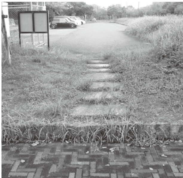
駐車場から車いすで行けない投票所
