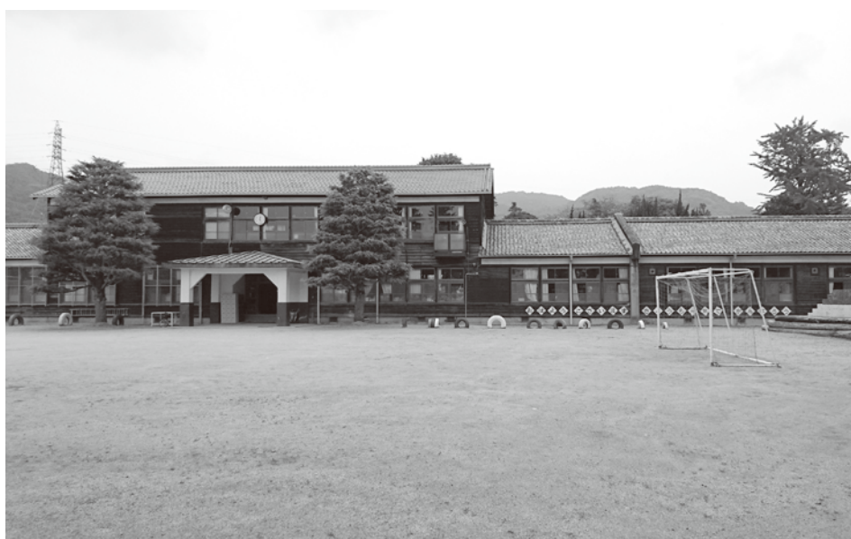
耐震補強工事で安心な学校生活に（恭仁小学校）
