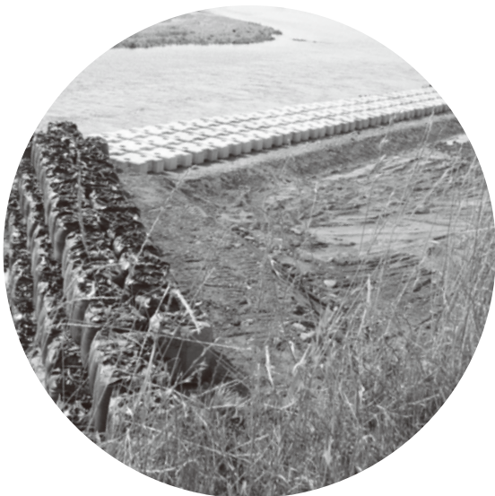
木津川河川敷保全工事の現状
