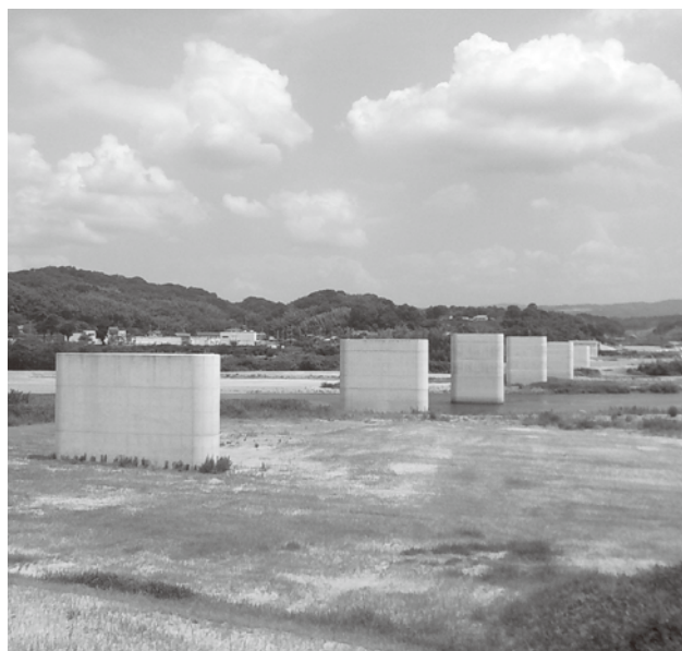
木津川をまたぐ新架橋
