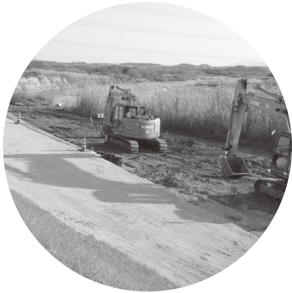
護岸工事前の車両進入路造成工事（農地崩落現場の下流域）
