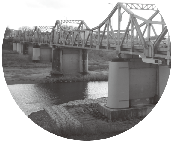
耐震補強工事が進められている泉大橋
