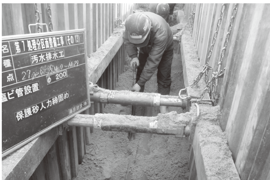
進む下水道工事
