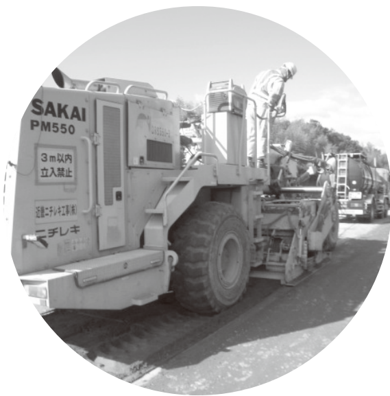
整備が進む市道
