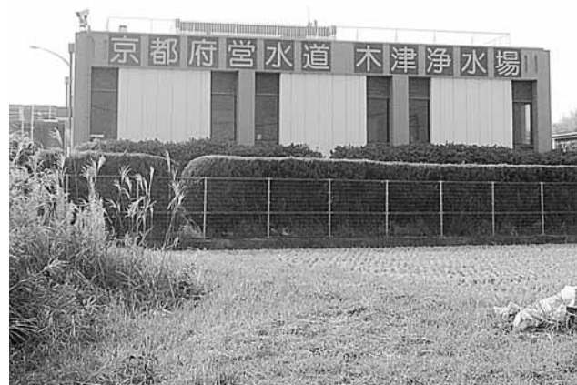
木津地域へ受水している府木津浄水場
