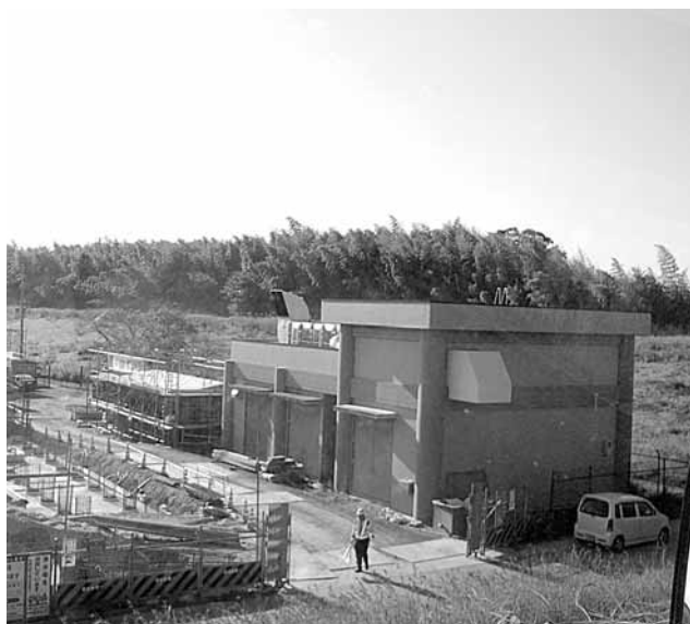
改修中の宮ノ裏浄水場
