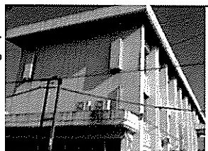
改修前の中学校舎
