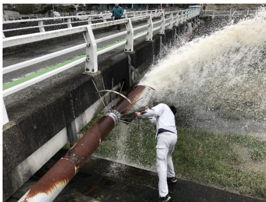
水管橋の漏水状況（φ150 鋼管）
