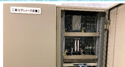
吐師受水場のテレメータ(遠隔監視)装置の更新工事
