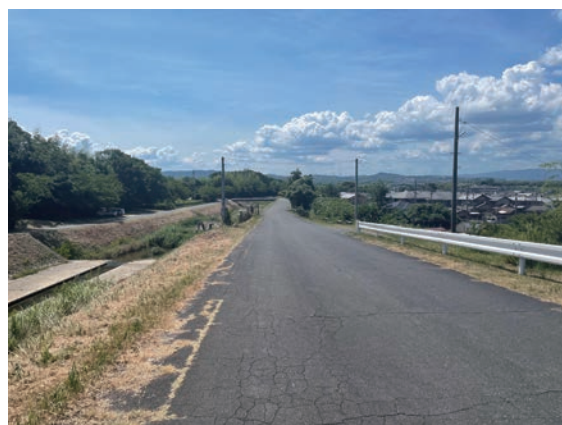
天井川となっている不動川（綺田） 【川底が周囲の家の屋根より高くなっています】
