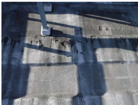
防水シートの破損
