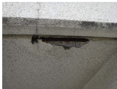
剥離・鉄筋露出
