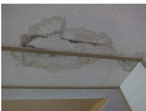
最上階天井の漏水跡
