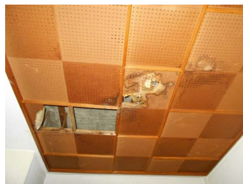
最上階天井の漏水跡
