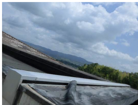
防水シートの破損
