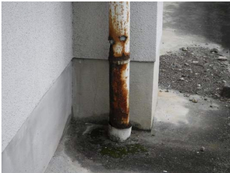
(設備) 排水管の腐食
