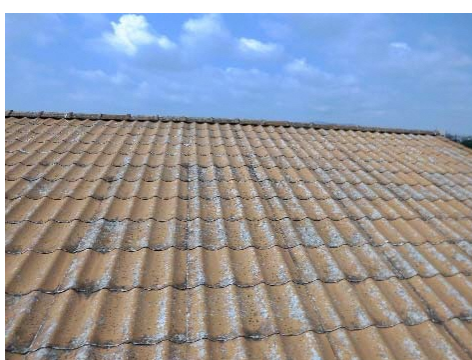
屋根葺材の劣化
