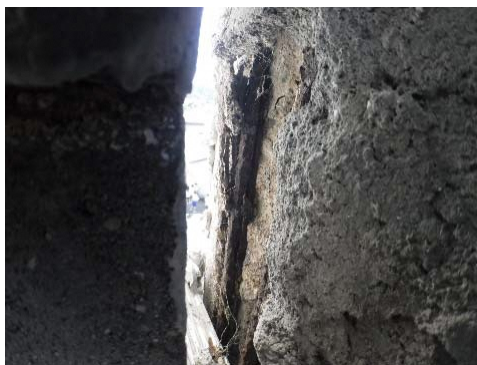
剥離・鉄筋露出
