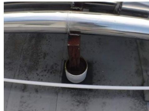
(設備) 架台の腐食
