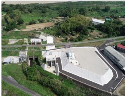
[小川内水排除施設（整備中）]
