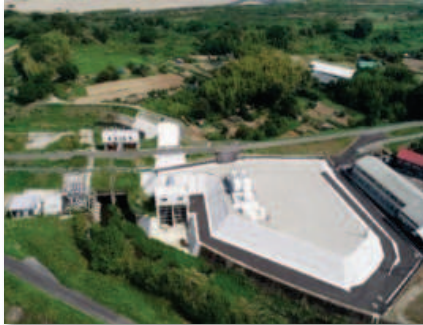
[小川内水排除施設（整備中）]
