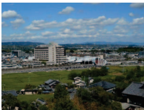
〔木津駅東側地区〕
