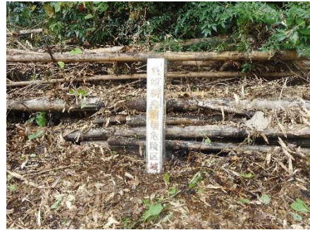
〔急傾斜地崩壊危険区域（鹿背山）〕
