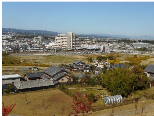
[木津駅東側地区]
