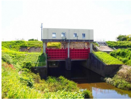
〔木津合同樋門〕
