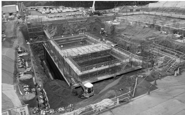
【ごみピット側壁部分の配筋工事の様子】
