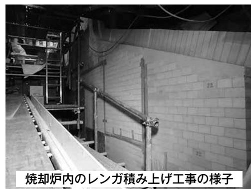
焼却炉内のレンガ積み上げ工事の様子
