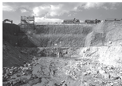
【炉室・機械室工区の均しコンクリート打設後の様子】
