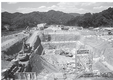
【炉室・機械室工区の均しコンクリート打設中の様子】
