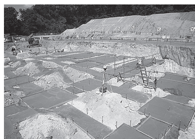
【炉室・機械室工区の均しコンクリート打設後の様子】
