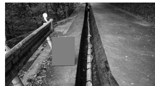
配水管布設替
