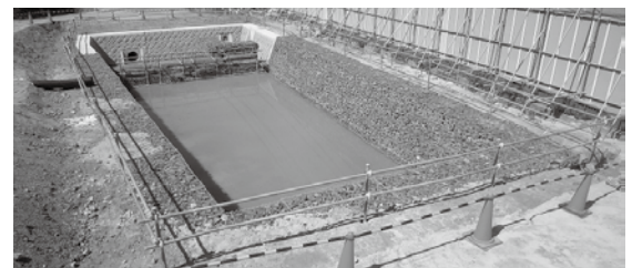
工事期間中の濁水対策の沈砂池が完成しました。（平成26年7月）
