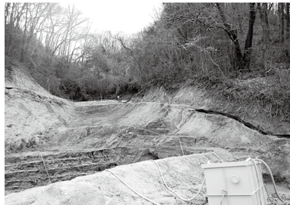
一般廃棄物の撤去後の様子
