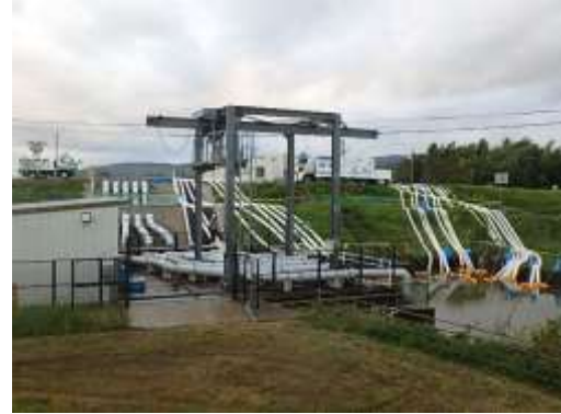
木津合同樋門（内水排水状況）
