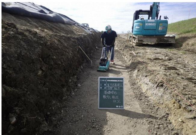
ブロック張工の重力式基礎工
