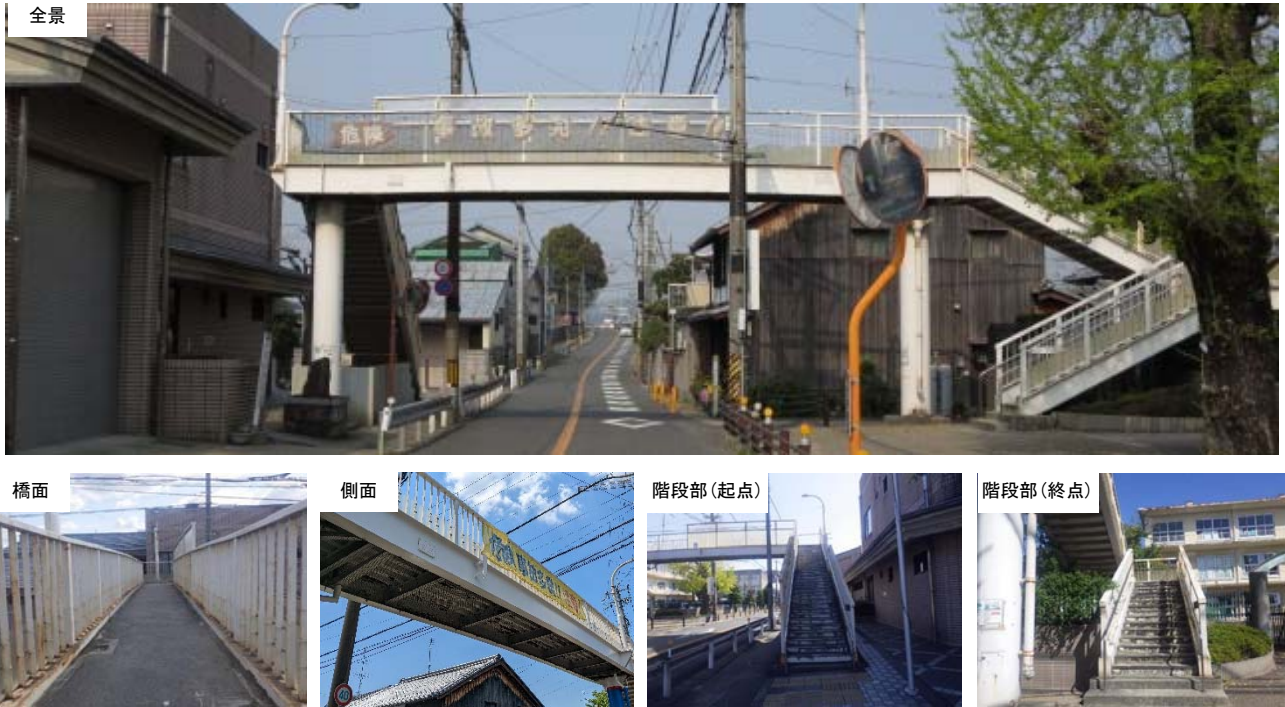
図2 木津横断歩道橋写真
