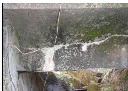
■ コンクリートのひびわれ
