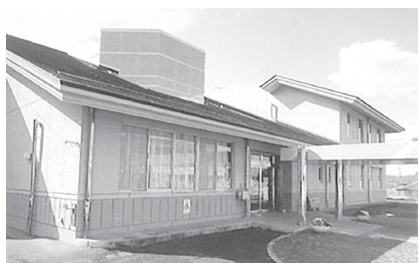
改修を行ったやすらぎコミュニティセンター・山城保健センター
