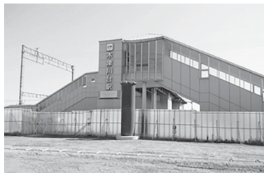
工事が進む木津川台駅前線
