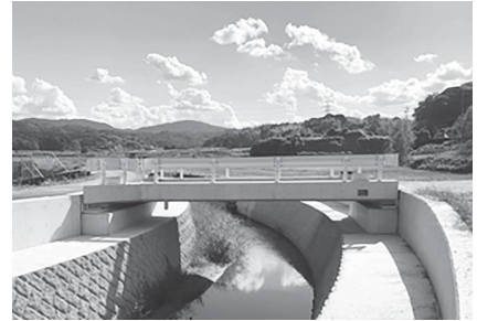
架替工事が完了した柳原橋
