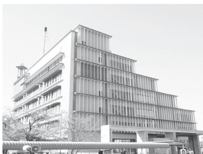
外壁等改修工事を行った本庁舎
