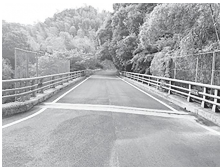
補修工事に着手した芦原谷橋
