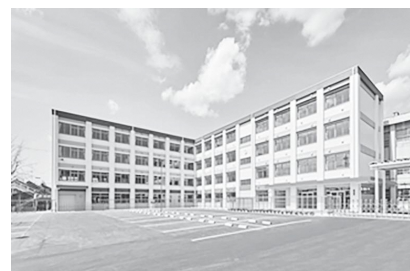
完成した木津小学校新校舎
