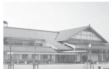
改修工事設計を行った中央交流会館
