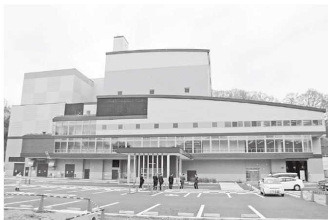
クリーンセンター外観
