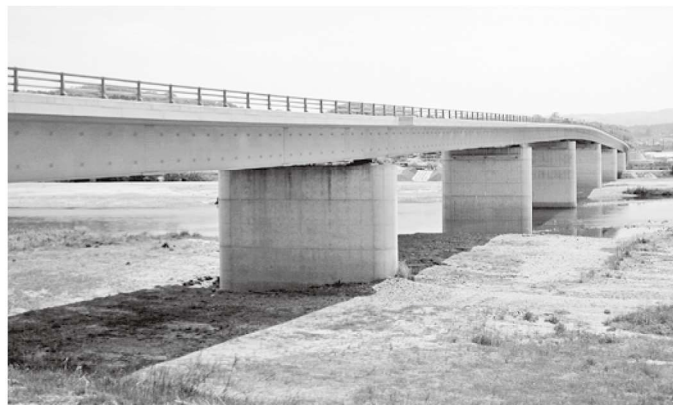
東中央線木津川架橋
