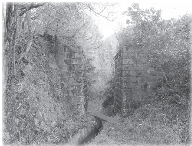
大仏鉄道遺構（鹿背山橋台）
