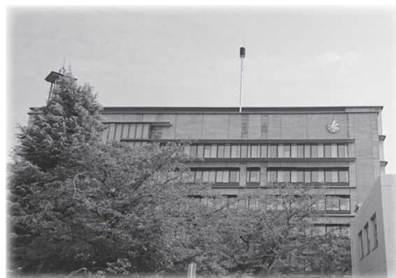
本庁舎に設置した防災行政無線親局
