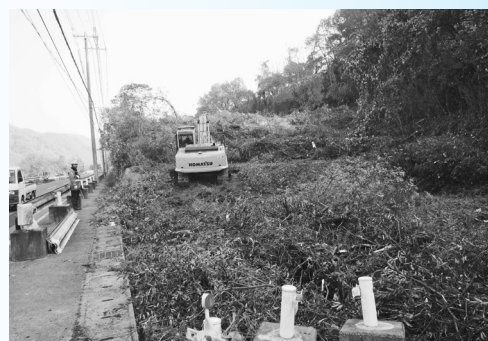
クリーンセンター敷地造成工事に着手 (平成25年12月5日撮影)
