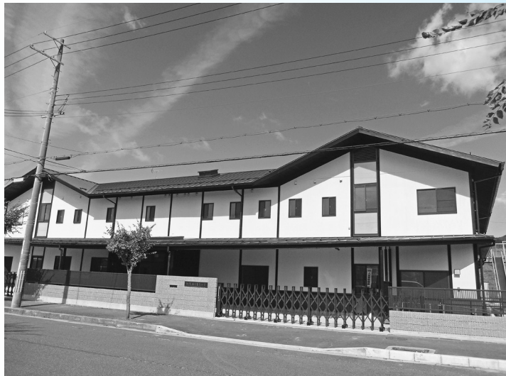
介護基盤緊急整備等特別対策（加茂地域）
