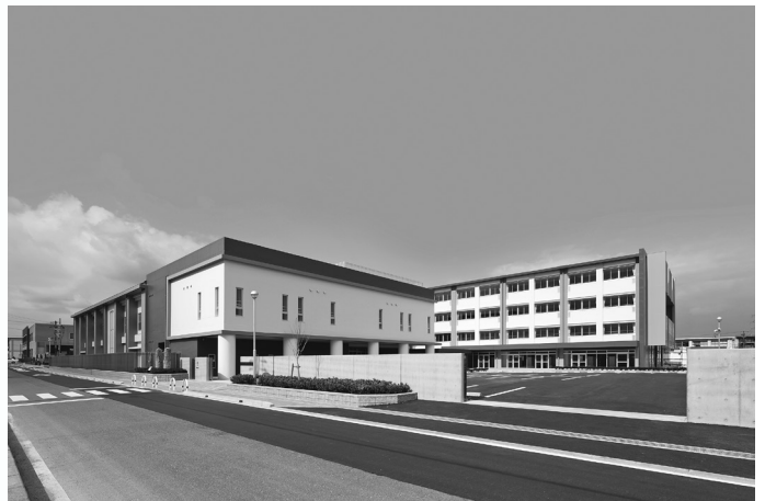
改築して新しくなった木津中学校
