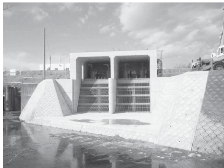
設置した吸水槽及び排水ポンプ
