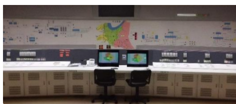
吐師受水場 遠隔監視システム
