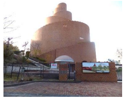
タツタタワー木津川市
